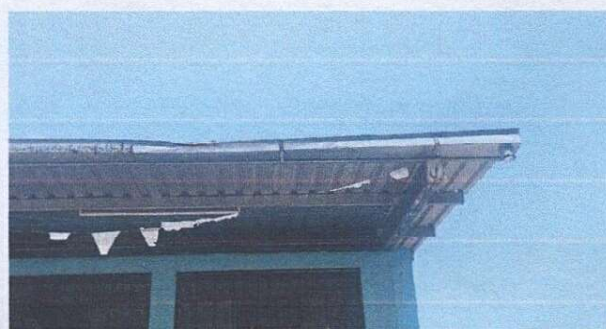
Foto 4: Sustitución de canal y bajadas de aguas pluviales en aula de segundo nivel
