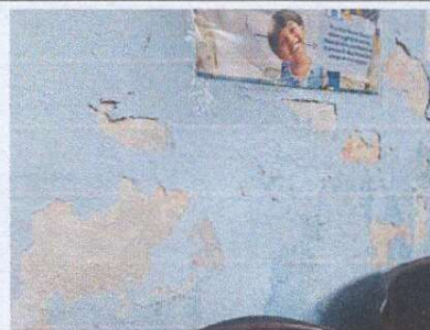
Foto 2: Resanado de pared exterior de la dirección aplicación de zika zero salitre repello y cernido en area de direccion
